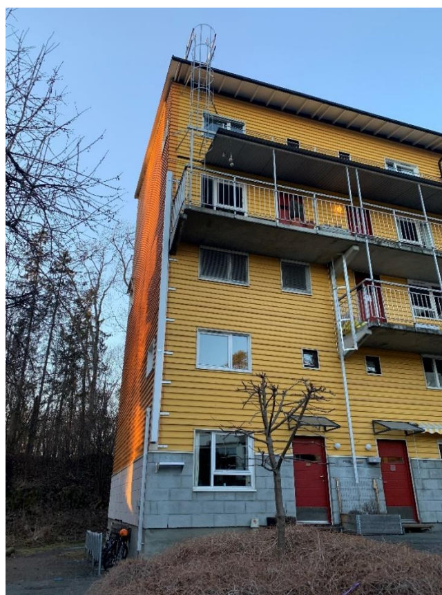
SH2 til venstre og SL til høyre
